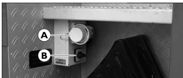
[102] Caja de enchufe (A) y pulsador (B) para la bomba de emergencia con alimentación externa en la subida a la plataforma; es posible otro lugar de montaje
